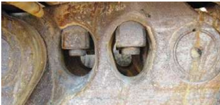
Detail of track chain during inspection at 1500 working hours. Detalhe das correntes da esteira durante a inspeção às 1500 horas de trabalho.
